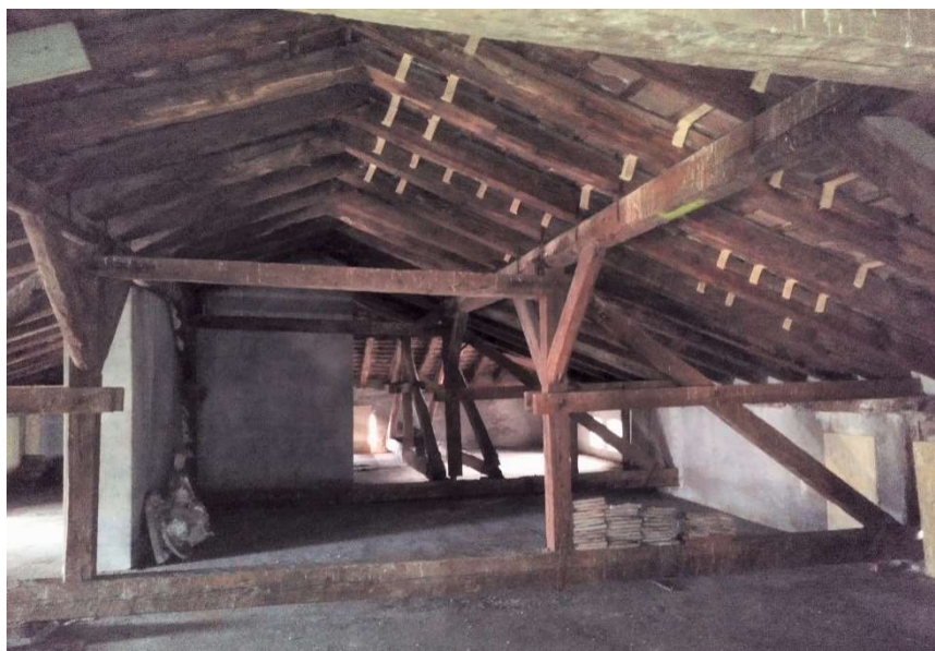
• Particolare delle orditure interne della copertura a falde
