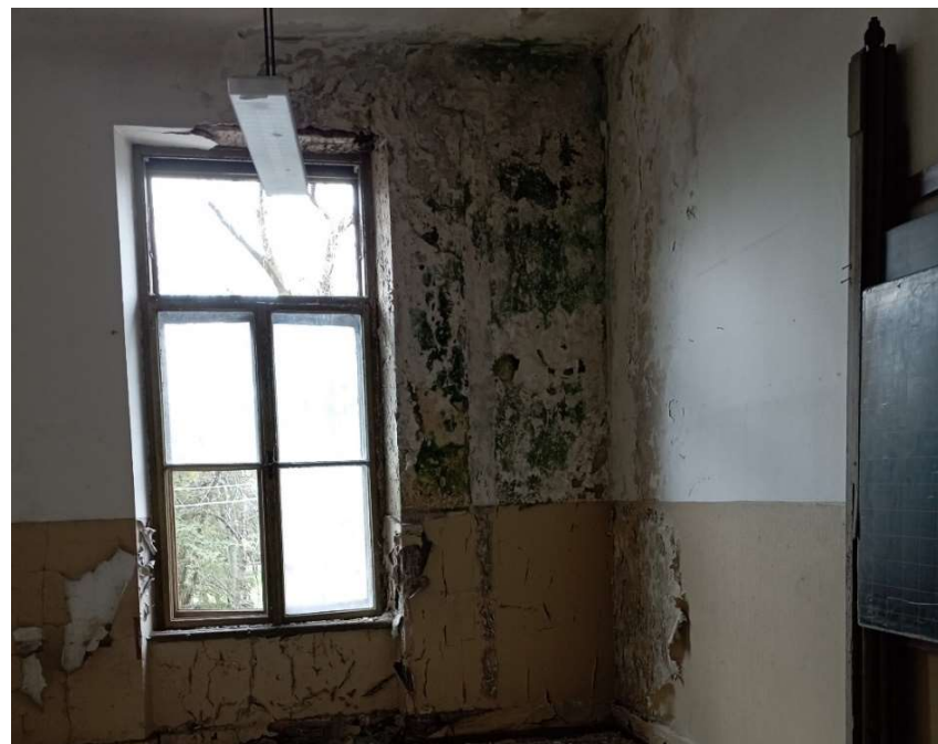
• Particolare dei fenomeni di infiltrazione degli ambienti interni
