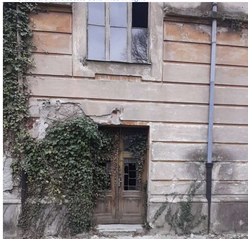
• Particolare della vegetazione infestante sul paramento murario esterno
