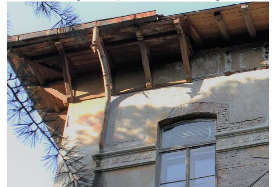
• Particolare del pluviale di gronda
