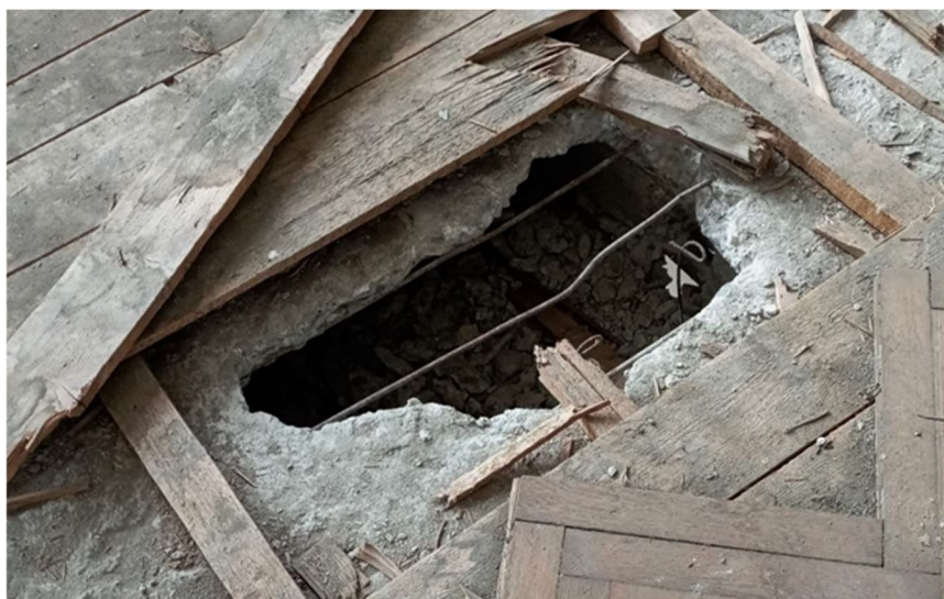
• Particolare della stratigrafia della pavimentazione interna
