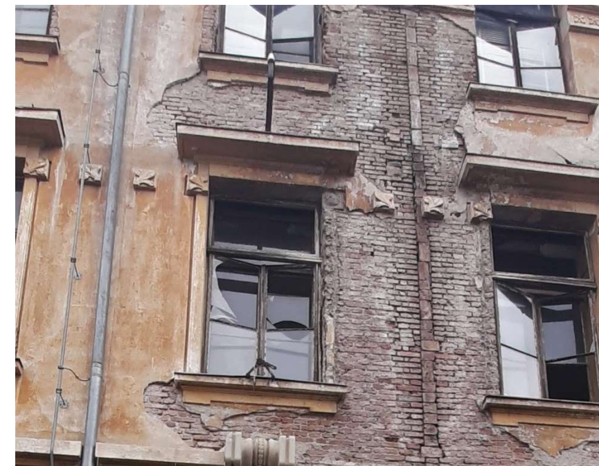
• Degrado esterno con distacco di intonaco, cornici e decori e infissi divelti
